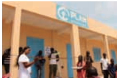
新しく完成した3教室が入る校舎
