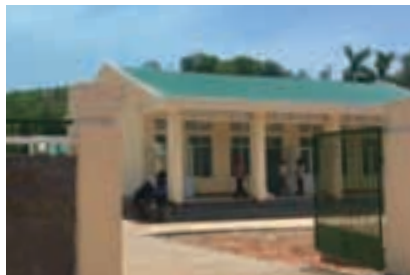
完成した校舎と校門。校庭も整備された
