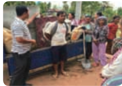
家庭用トイレの設置工事
