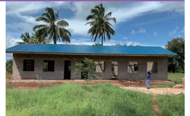
バラカ小学校に新たに建設中の教室
