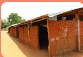
プロジェクト実施前の校舎
