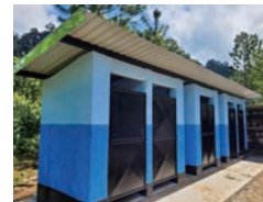
男女別および教師用トイレを新設
