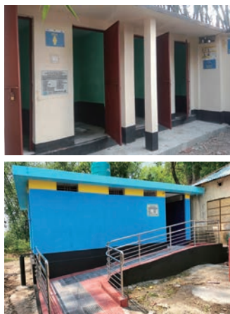
新設された男女別のバリアフリートイレ
