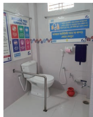
完成したトイレの内部
