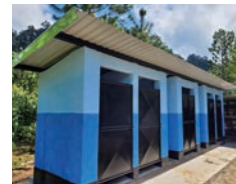
男女別および教師用トイレを新設
