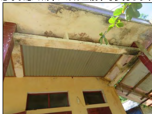
教室の壁には亀裂や穴があり、雨風が吹き込んでくる。教室の屋根・天井も損壊が激しいです。
