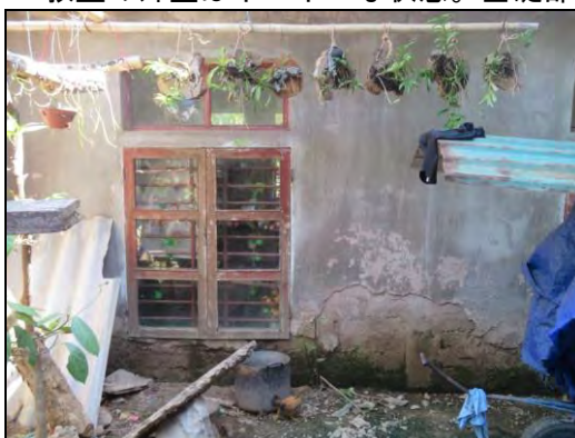
教室の壁には亀裂や穴があり、雨風が吹き込んでくる。教室の屋根・天井も損壊が激しいです。
