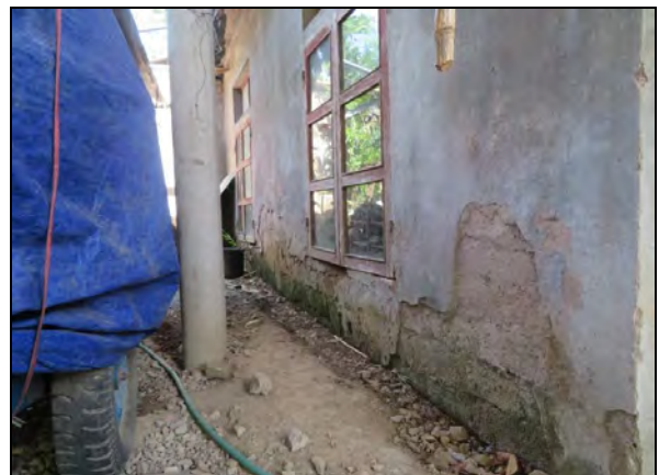
教室の外壁はボロボロな状態。基礎部分も劣悪な状態で雨季には床上浸水も多発します。
