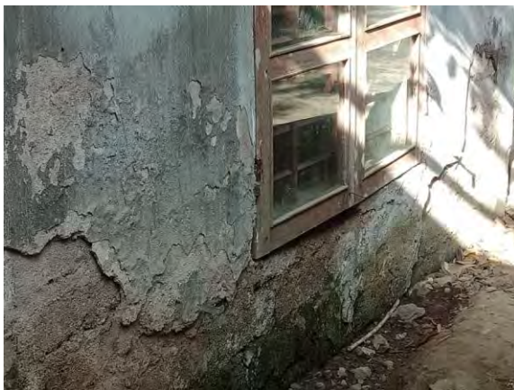
教室の外壁はボロボロな状態。基礎部分も劣悪な状態で雨季には床上浸水も多発します。
