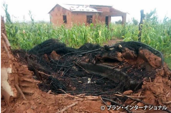
ジンバブエを襲ったサイクロンにより崩壊した家屋
